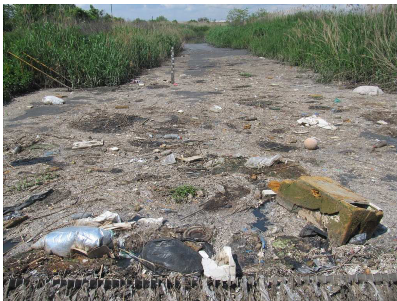
Slika 2. Ulazni kanal Subotičkog prečišćača posle obimne kiše
