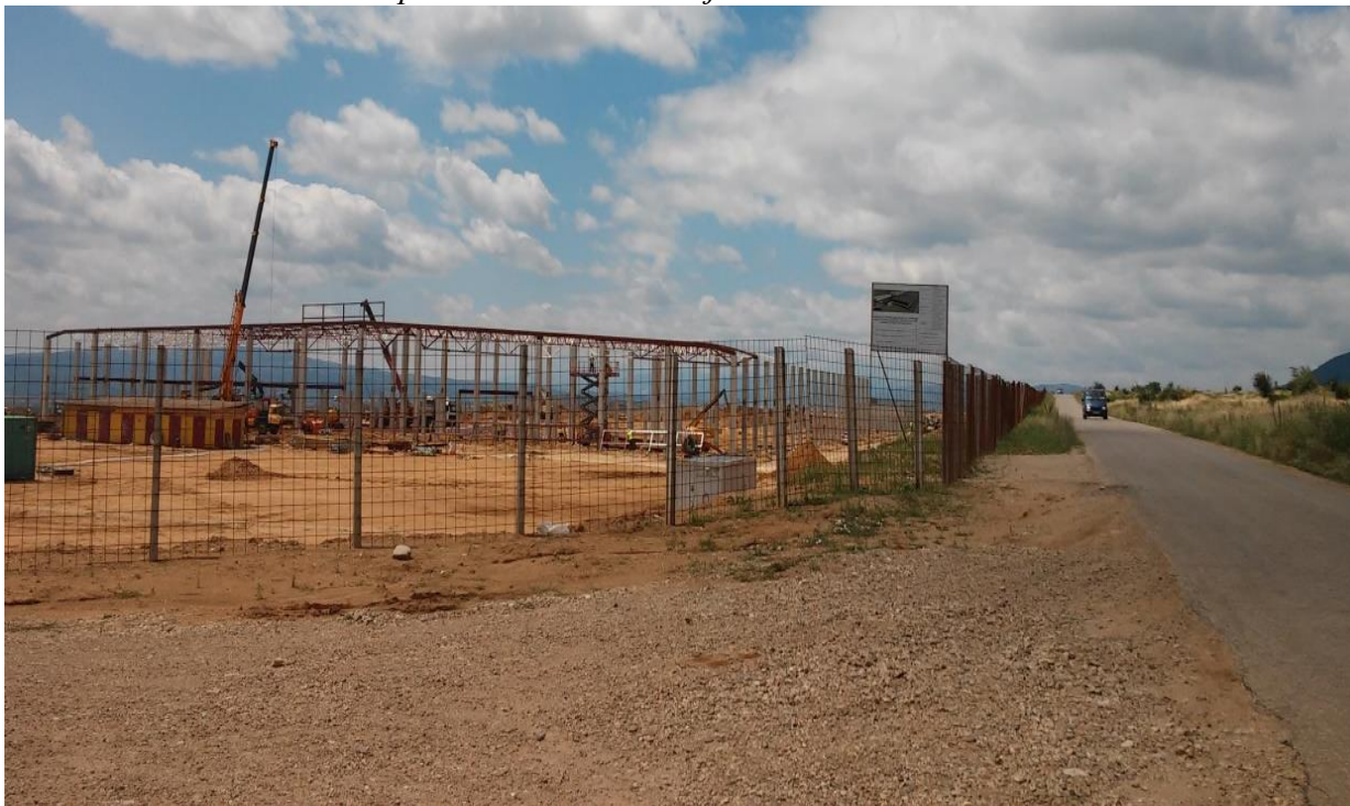
Слика 18. Изградња погона италијанског гиганта "ГЕОКС"
